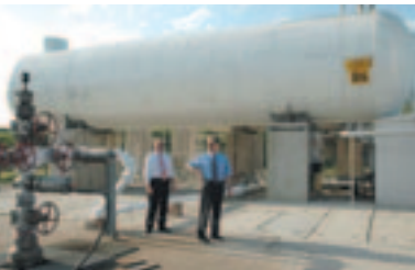
CO 2 wird in Bohrlöcher eingetragen, um die geförderte Ölmenge zu erhöhen.
